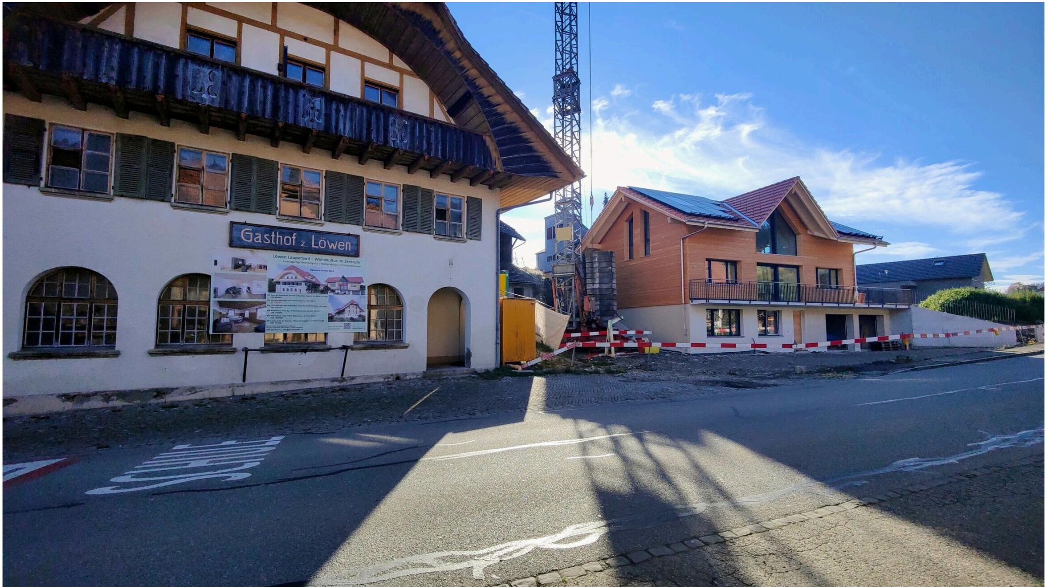
Ansicht West (Altbau) links, neues EFH rechts (verkauft))
